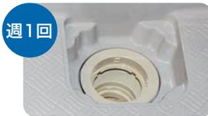
①上目皿、ヘアキャッチャー、防臭パイプ、封水筒の順に取り外します。
