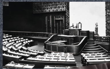
※写真は1931年貴族院(現参議院)議事堂の内装工事
